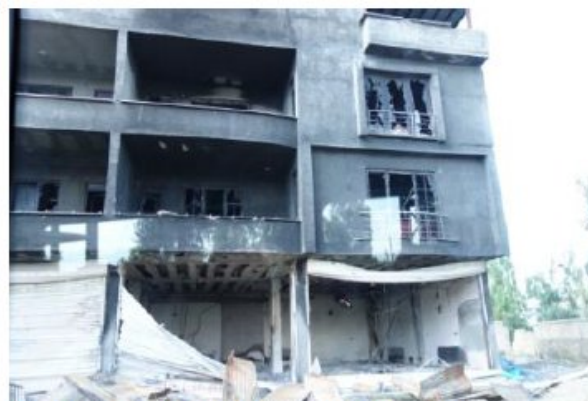
Yüksekova – zerschossenes, verbranntes Haus
